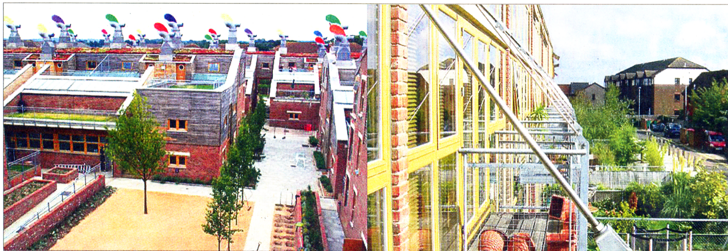
BedZed. Au sud de Londres en Angleterre, dans la ville de Sutton, un quartier écologique a été inauguré en 2002.
