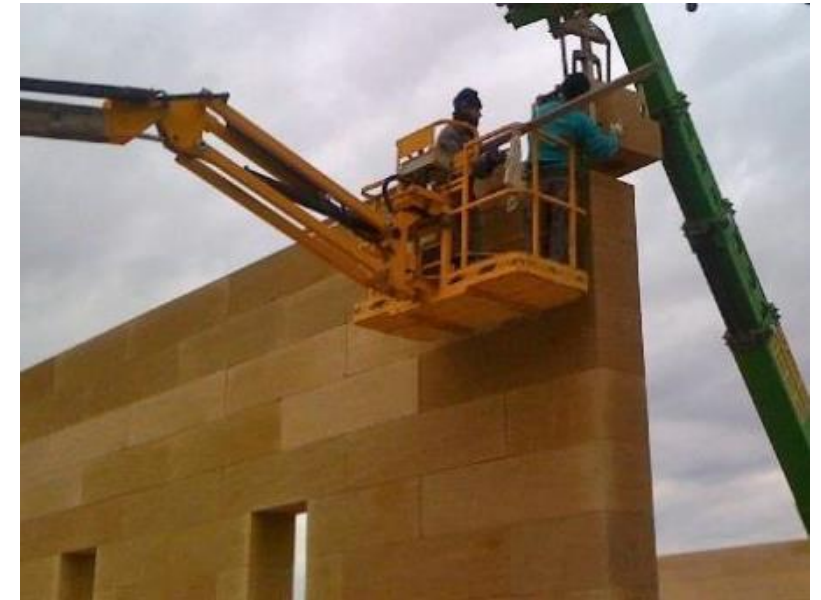
Blocs de pierre sciés en exemple d'interface atrium / espace bureau
